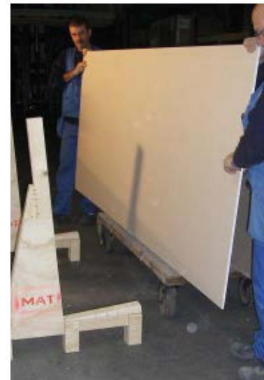
Van transportkar naar bokje, met 2 personen, plaat voor plaat.
